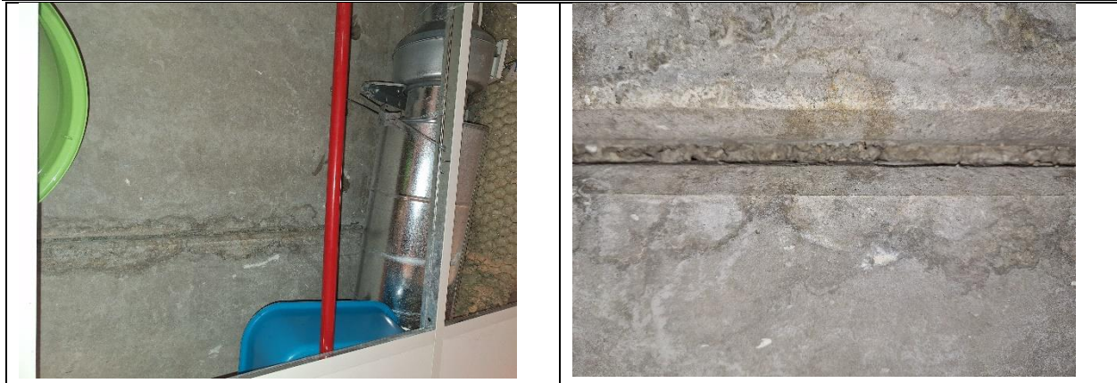
Foto 5; 6 : Paneelide vuuk on lahti ja paneelide alumine kiht on niiskuskahjustusega. Ülevaatuse ajal oli lagi kuivanud. Läbijooksu olla kevediti, mitte tugevate vihmade ajal.
