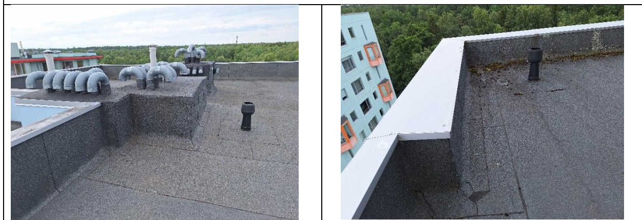
Foto 8: Katusel selgus ,et kommunikatsiooni sahti lagi on ventilatsiooni torude ümber korralikult suletud katusekatte materjaliga. Sajuvesi kommunikatsioonide sahti ei pääse.
