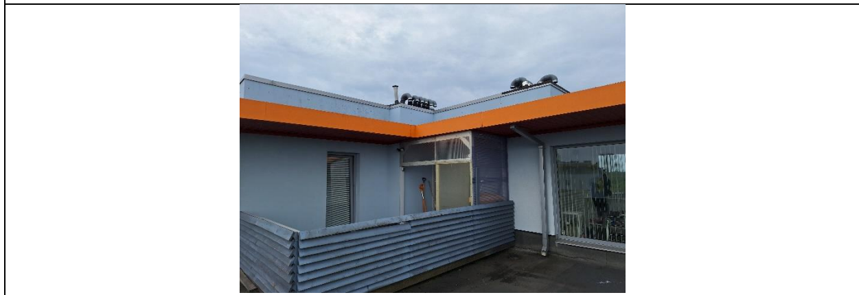
Foto 7: 9nda korruse katusekorter mille rõdult paistavad katusel ventilatsiooni korstnad, mida oli võimalik redeliga rõdult katusele mines.
