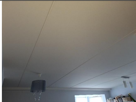
Foto 2: Korteril elutuba kus vahelaele on pikad r/b õõnespaneelid, milliste vuugid on elastse vuugitäitega viimistatud, ja vuugid on suletud, vuukides pragusid ei ole.
