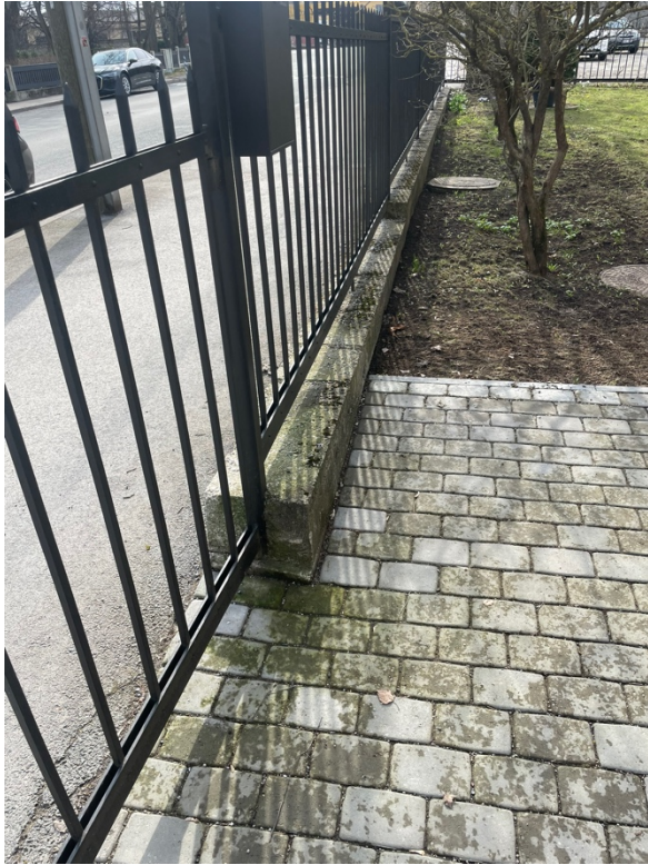
Vaade jalakäijate värava all olevale betoonalusele (läbimõõt ca 30 cm)
