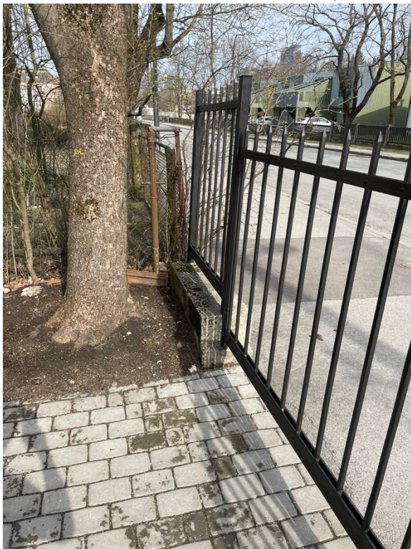
Vaade aia all olevale betoonalusele (läbimõõt ca 30 cm)
