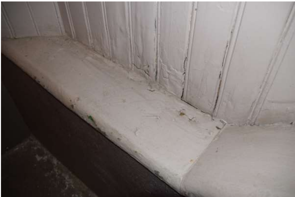
Foto 4. Tugeva seenkahjustuse tunnustega laudis keldri trepi kõrval
