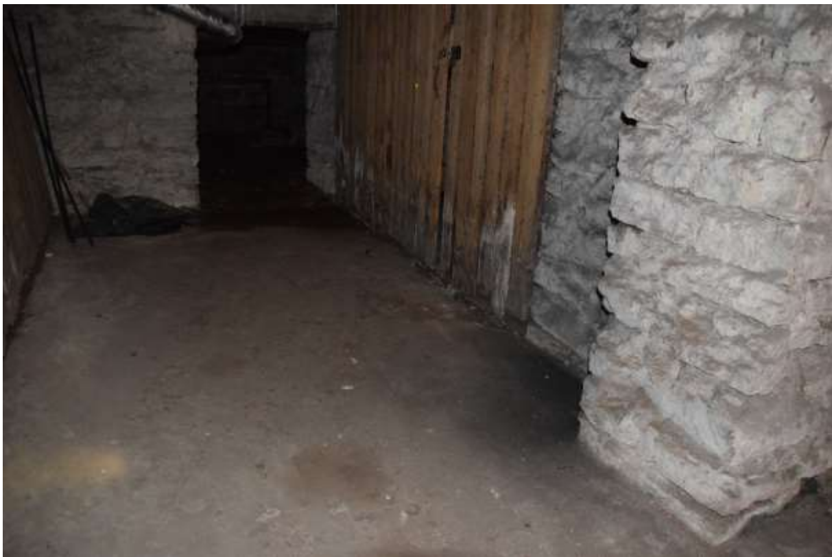
Foto 3. Seenkahjustusega keldribokside seinte alaosa
