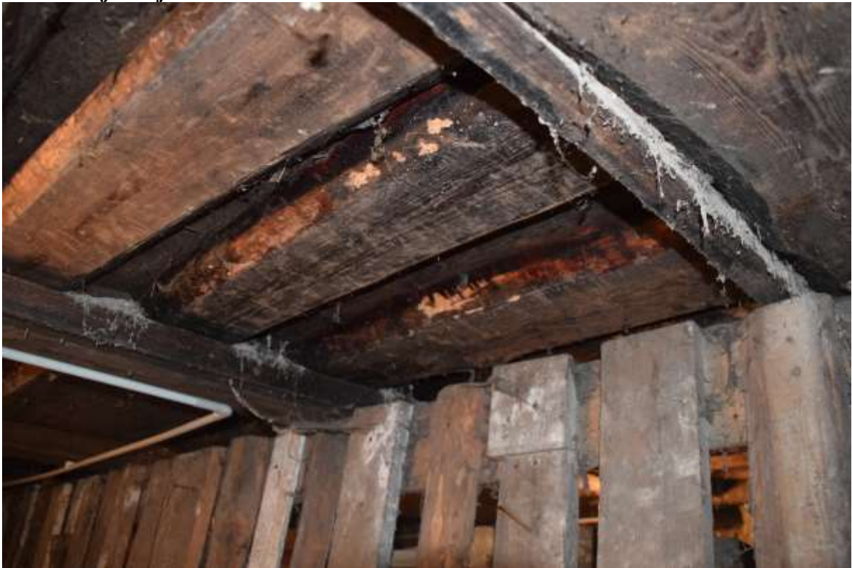
Foto 1. Hääletu toonesepa koorealuse kihi kahjustused taladel
