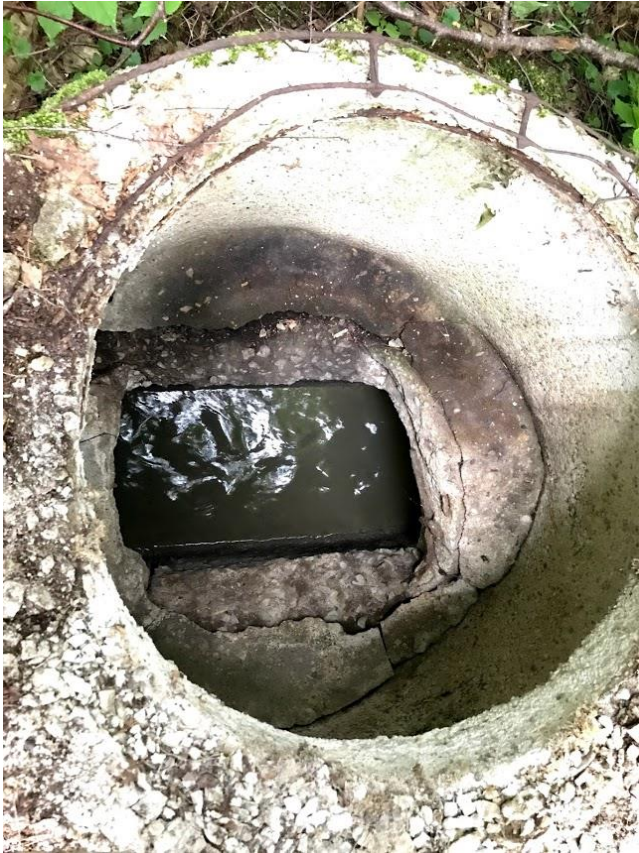
Pilt 5. Kaevu sisu (reovee voolamine suund on vasakult paremale)
