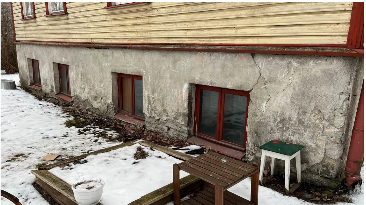
Rekonstrueeritav hoone, sokli vaade lõunast
