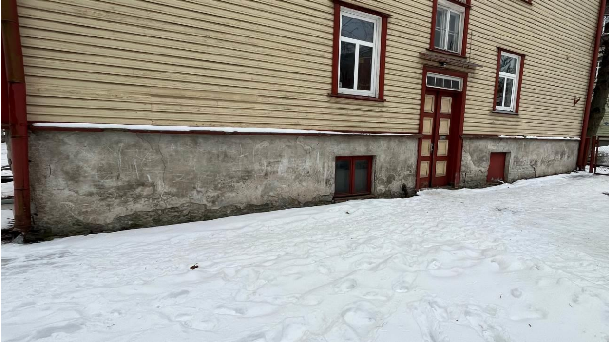
Rekonstrueeritav hoone, sokli vaade idast
