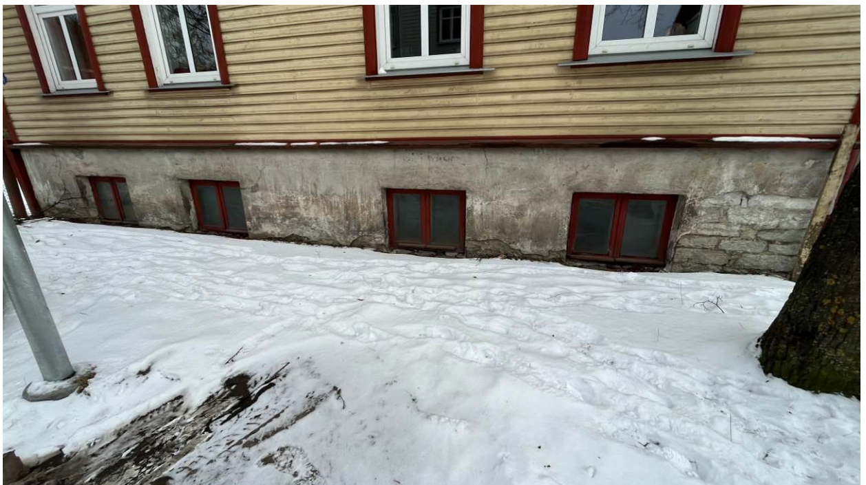
Rekonstrueeritav hoone, sokli vaade
