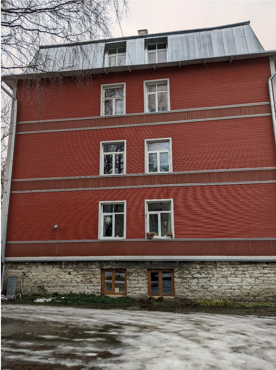
Foto 2 Olemasolev olukord. Vaade loode fassaadile
