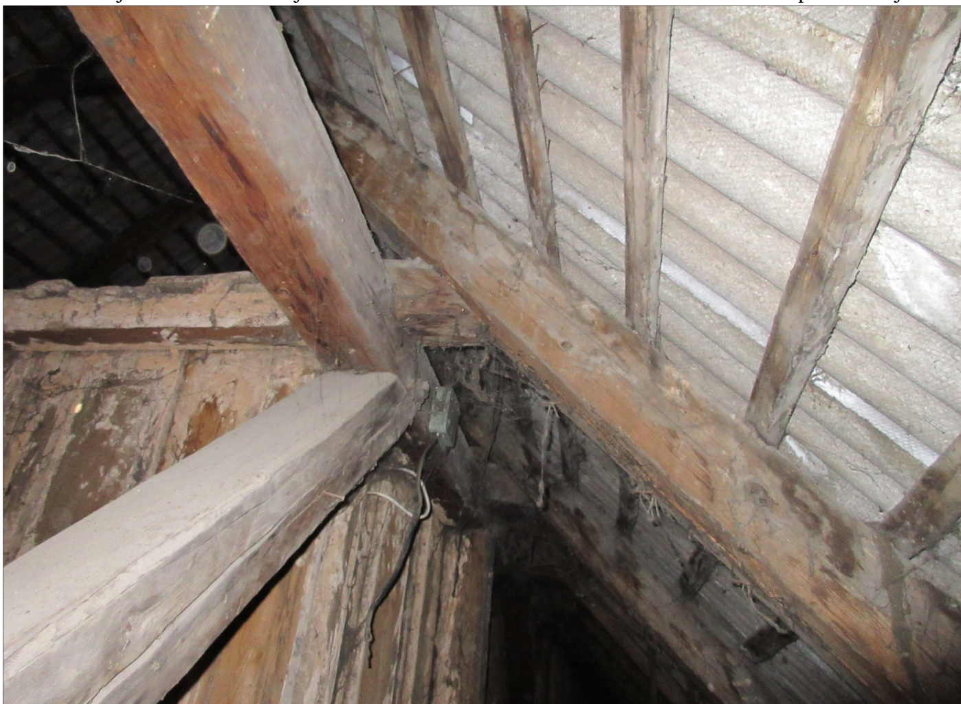
14. Säilinud algne katusekonstruktsioon
