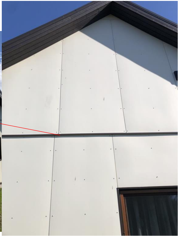
Foto nr 8 – vaade hoone lõunapoolsele küljele, mille viilualuses piirkonnas fikseeriti ehitusplaadil pragu (iseloomult analoogne eelnevatel fotodel esitatule), 03.05.2024.
