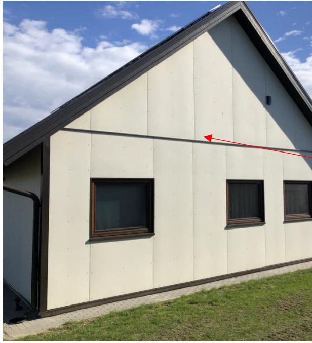
Foto nr 8 – vaade hoone lõunapoolsele küljele, mille viilualuses piirkonnas fikseeriti ehitusplaadil pragu (iseloomult analoogne eelnevatel fotodel esitatule), 03.05.2024.
