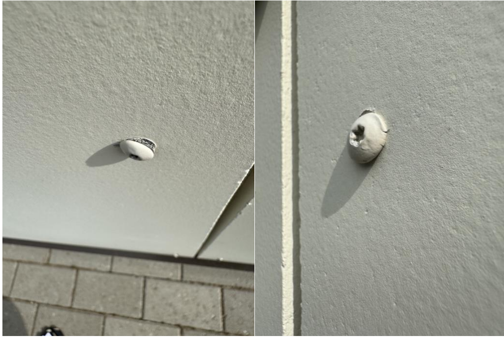
Foto nr 15 – fotod on tehtud lõunapoolse fassaadi kinnituskruvidest, 07.06.2024.
