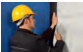
Fassaadimembraani ja kivikonstruktsiooni ühendamine Lehekülg 46
