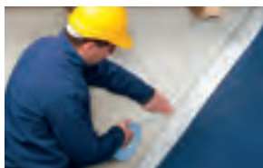
Katuse aluskatte ühendamine krohvitud müüritise või betooniga
