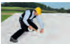
Aurutõkke paigaldamine konstruktsioonipealse soojustuse korral
