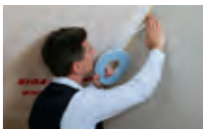
Aurutõkke ühendamine kivikonstruktsiooniga - krohvitud müüritis ja betoon
