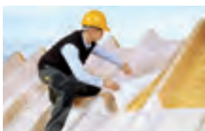
Aurutõkke paigaldamine: katuse renoveerimine väljastpoolt
