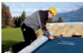
Katuse aluskatte paigaldamine
