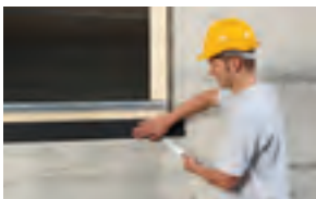
Akna ja kivikonstruktsiooni ühendamine Lehekülg 40
