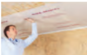
Aurutõkke paigaldamine lame-ja kaldkatustel
