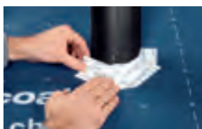
Katuse aluskatte läbiviigu tihendamine
