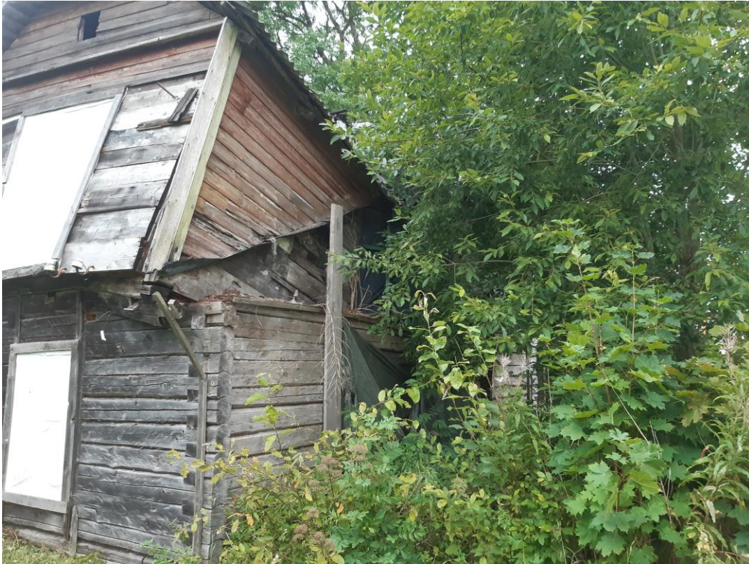
Foto 4: Vaade lammutatavale elamule põhjast.
