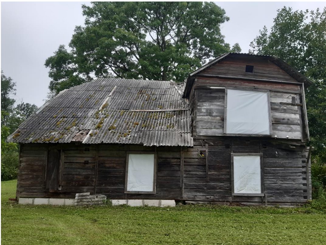
Foto 3: Vaade lammutatavale elamule idast.
