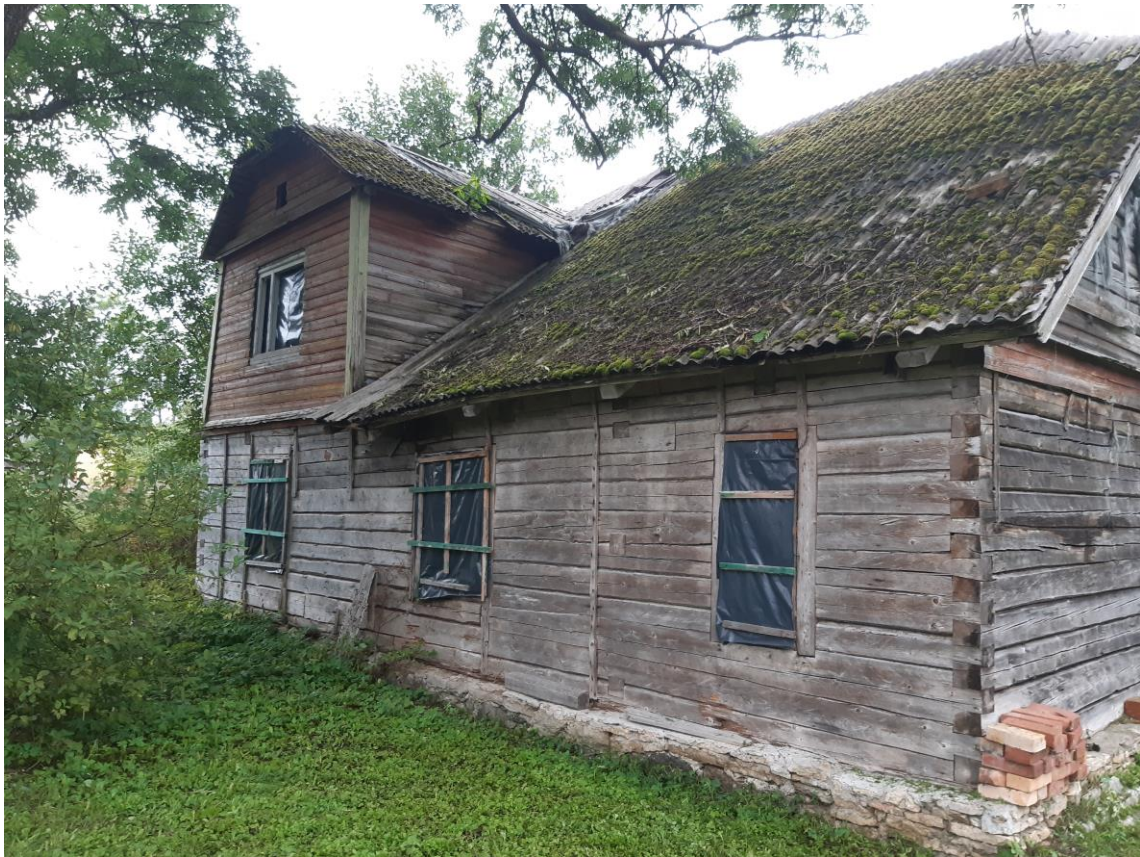
Foto 1: Vaade lammutatavale elamule läänest.
