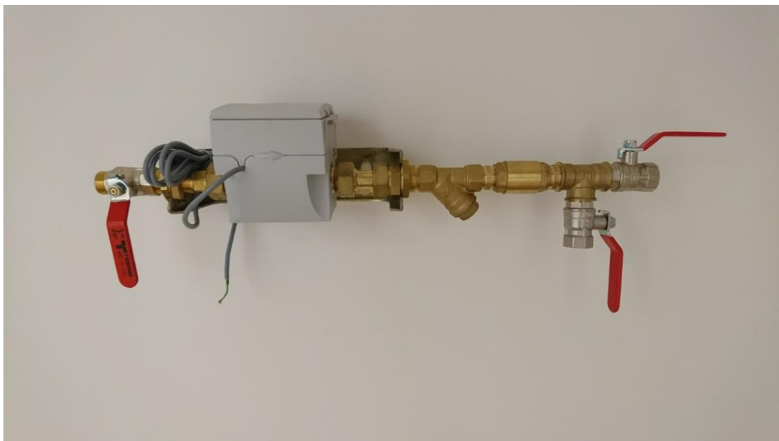
Veemõõdusõlme tüüpjoonis
