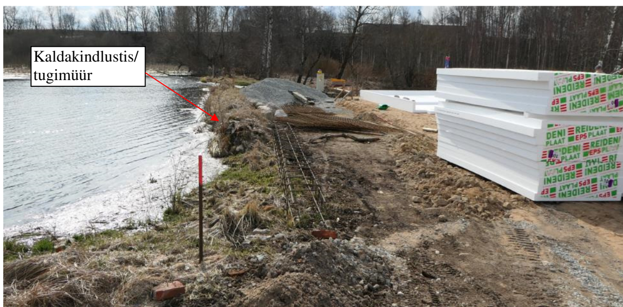
Foto 5. Vaade pinnaspaisule ja tugimüürile paremal kaldal
