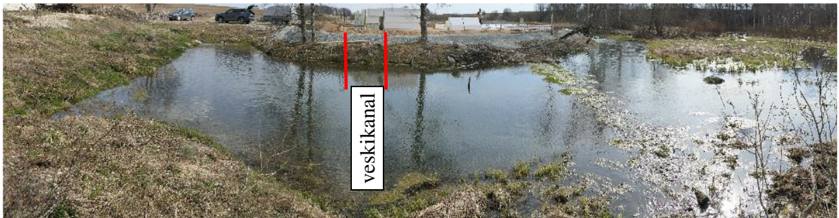
Foto 1. Vaade endisel veskikanali väljavoolule alavee poolt 12.04.2023.
