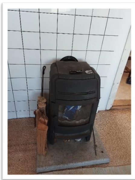
Kamin II korrusel (eemaldatakse)
