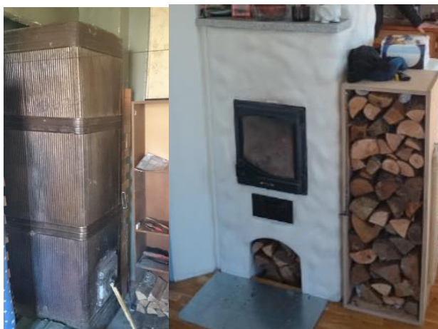
Foto 51 ja Foto 52. Ahjude ja kaminade seisukord (autori erakogu)
