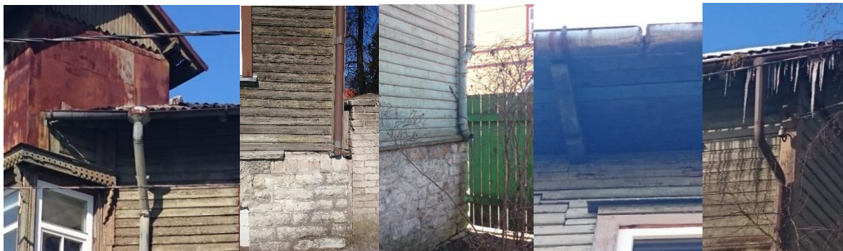
Foto 15, Foto 16, Foto 17, Foto 18 ja Foto 19. Vihmaveesüsteemi seisukord (autori erakogu)
