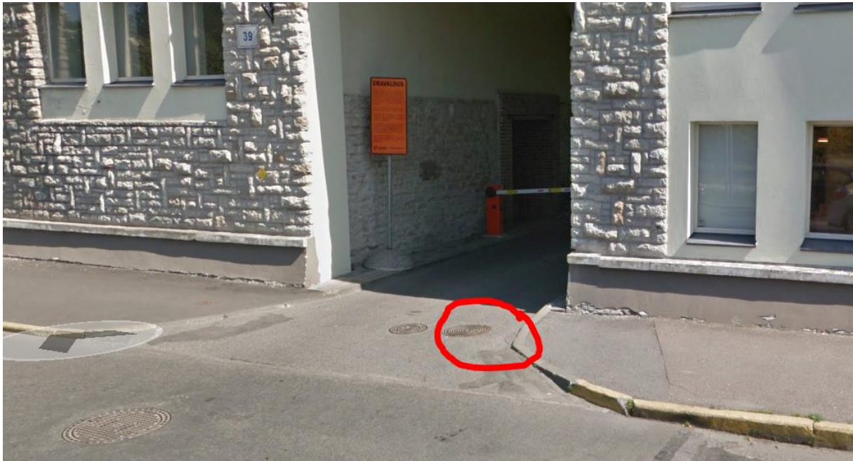
Foto 5- Sajuveekanaliseerimise eelsoo kaev
