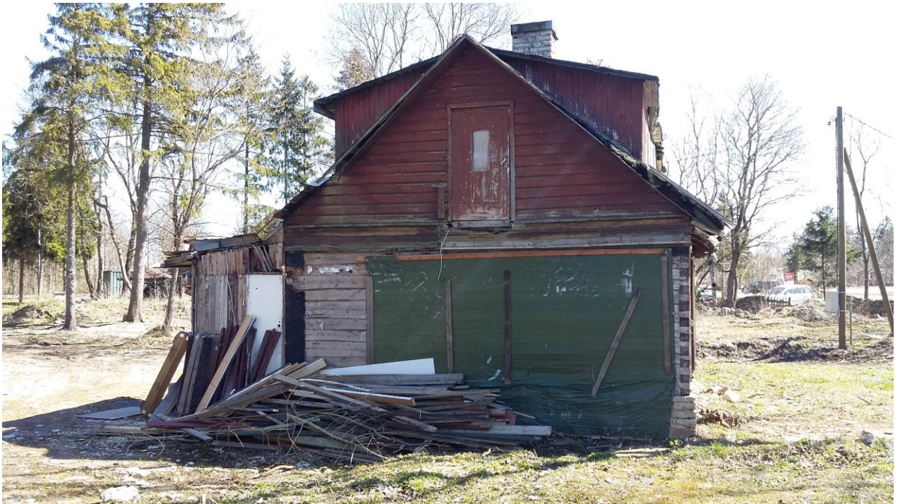
Foto 4: Vaade lammutatavale majale loodest.
