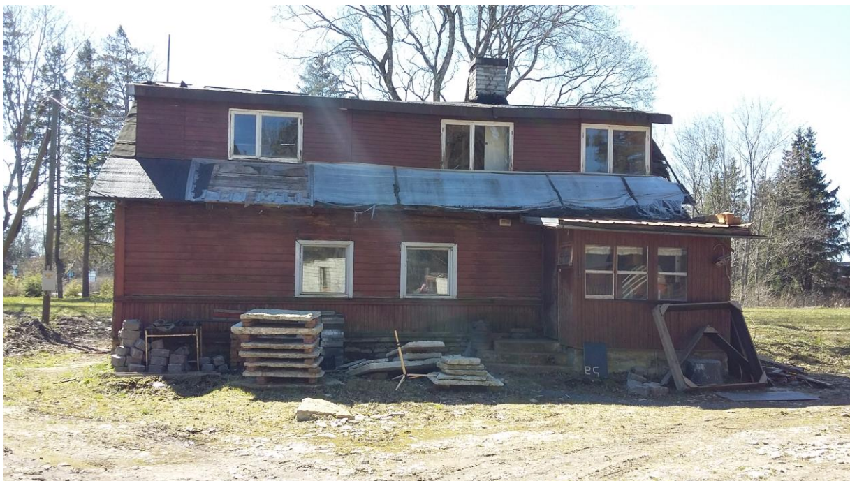
Foto 1: Vaade lammutatavale majale kirdest.
