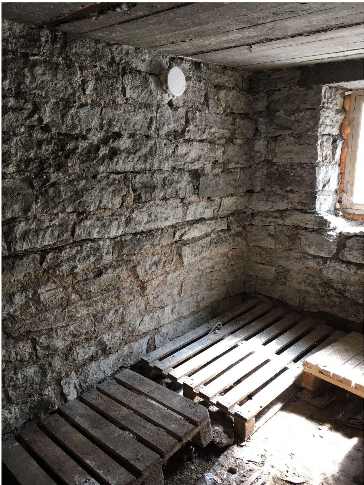
Näide keldri interjöörist. Boksi 8 kagunurk: viimistlemata päekivist välissein, raudbetoonvahelagi, muldpõrand, 2020. aastal puuritud värskõhuava. Foto 20.08.2020.
