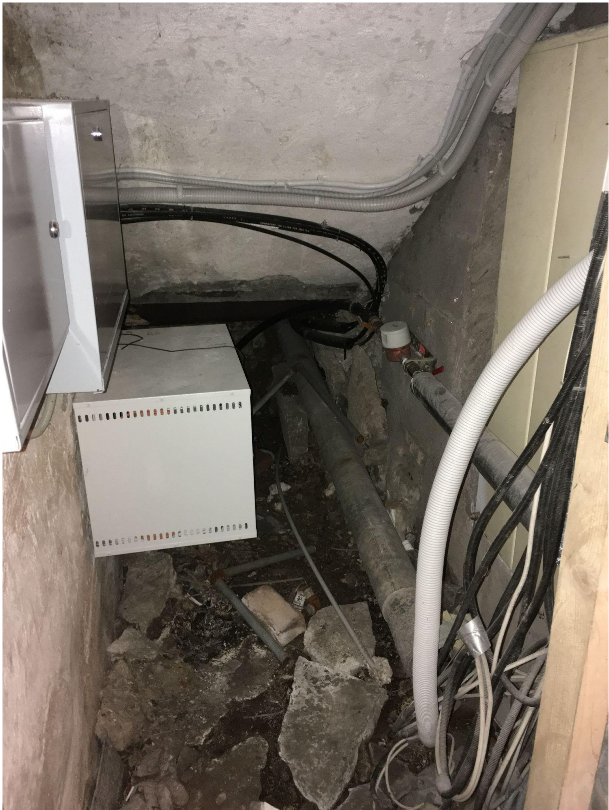
Vaade maja I korrusele viiva trepi all asuvasse veemõõdusõlme. Vasakpoolsel seinal asuvad sidekilbid (Elion, Elisa).
