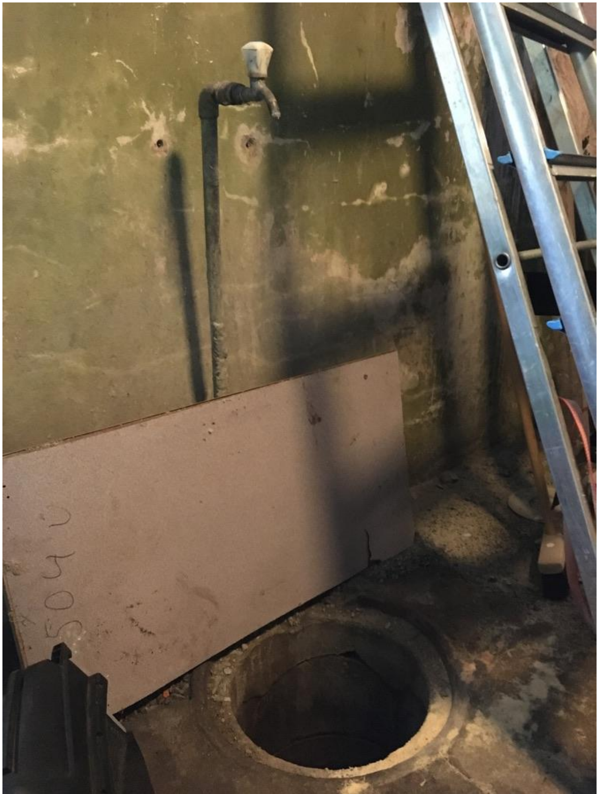
Boksi 2 pörandas asuv kanal.kaev (?). Sisemine diam. ca 380-400 mm. Põhjas vesi.
