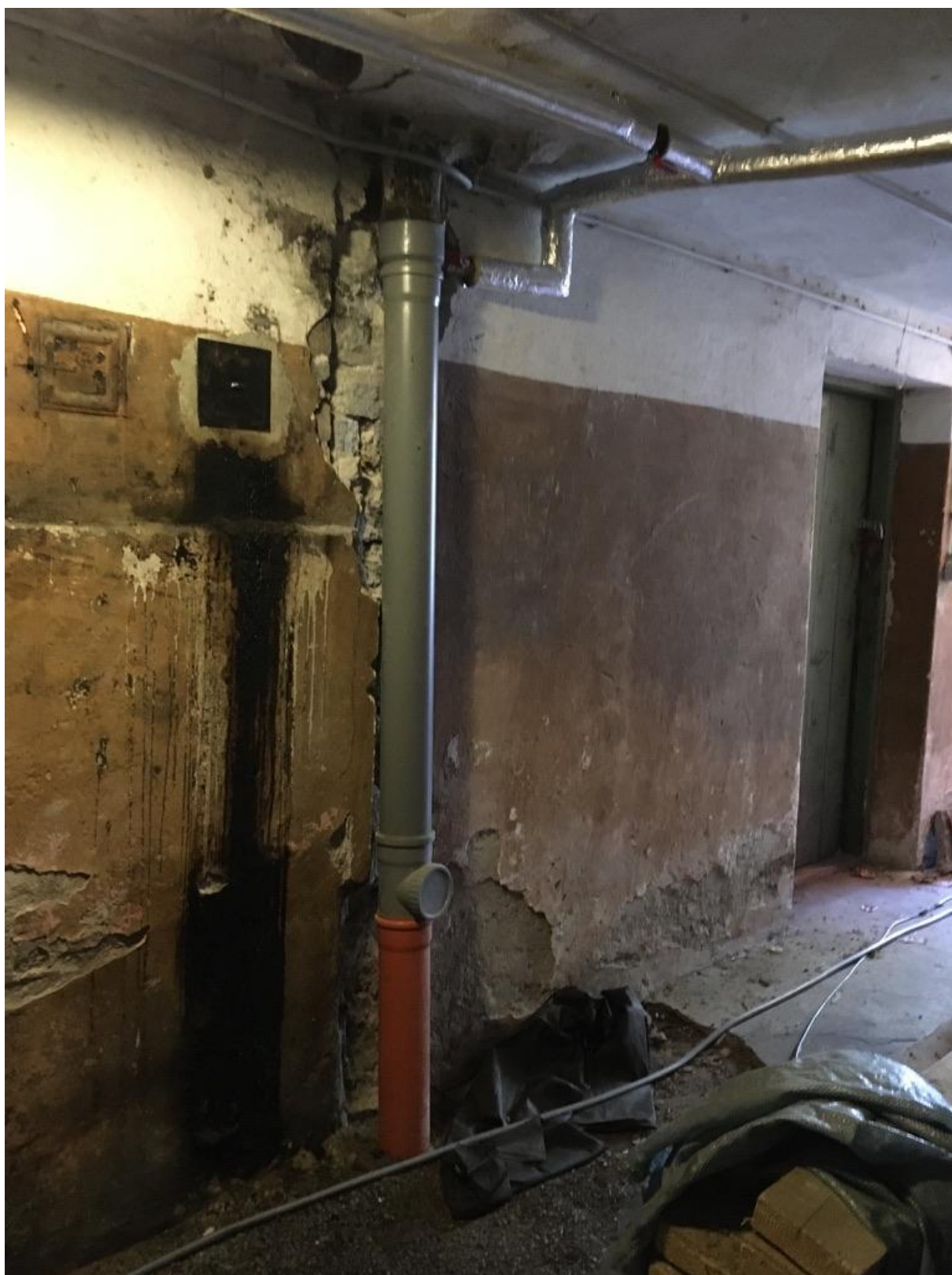
Kanal.püstak 1 ( : tn pool / läänepoolse kandeseina ääres).
