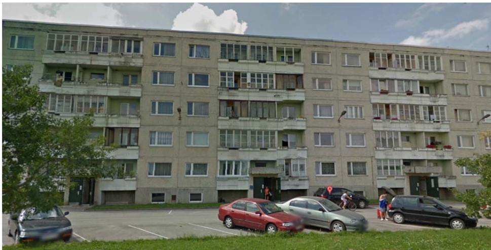
Pildid 1 ja 2 – Vaade maja otsa- ja esifassaadile.
